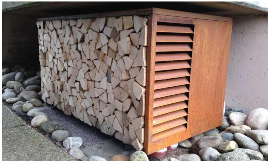
Abbildung 15: Holzverkleidete Ausseneinheit. Quelle: Thermosolution AG.
