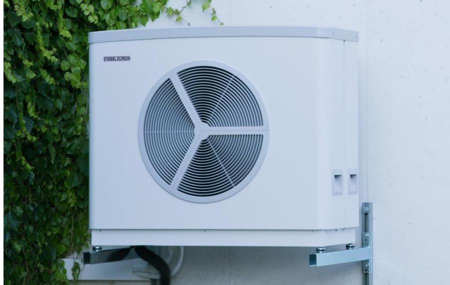
Abbildung 6: Beispiel einer Ausseneinheit einer Splitwärmepumpe. Quelle: Stiebel Eltron.
