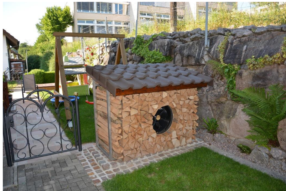
Abbildung 13: Visuelle Integration einer verkleideten Ausseneinheit. Quelle: Striega Therm AG.
