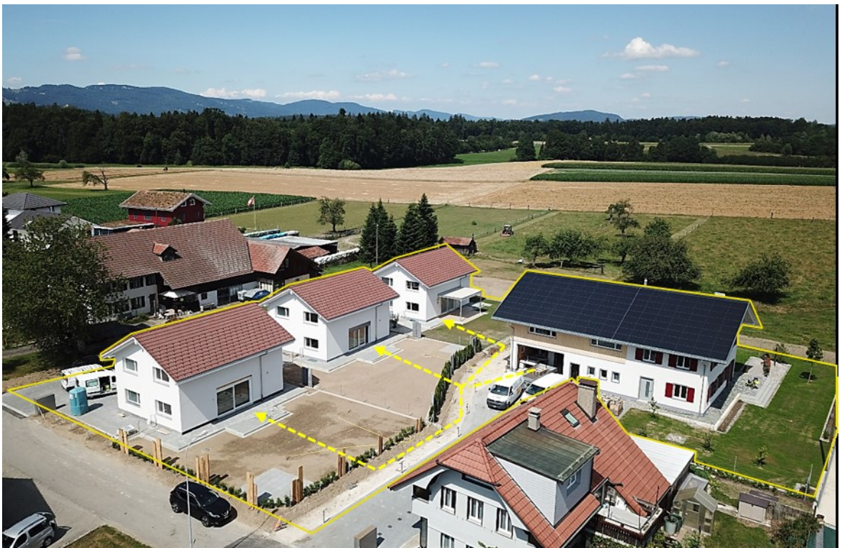
Abbildung 1: Vier Einfamilienhäuser bilden einen Zusammenschluss zum Eigenverbrauch von Solarstrom (Bildquelle: clevergie AG)
