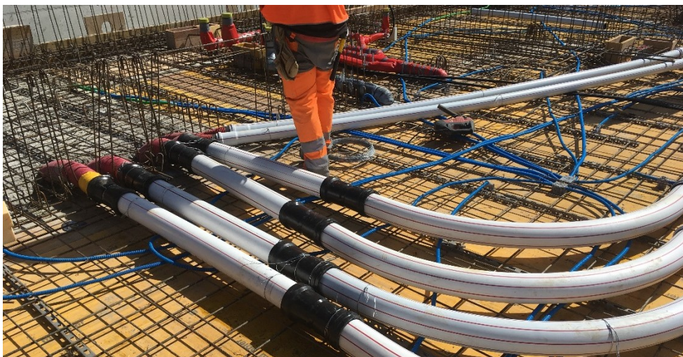
Abbildung 9: Foto vom Bau der privaten Leitungen (Bildquelle: Oasis Patrimonium / Romande Energie).
