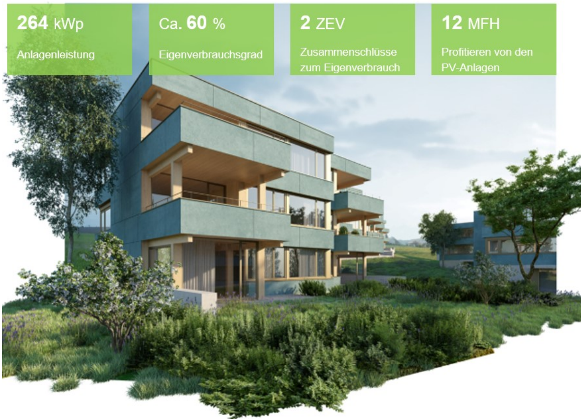
Abbildung 3: Im Wohnquartier Ämet in Birmensdorf entstehen 12 Mehrfamilienhäusern. Dabei werden zwei ZEV über je 6 Gebäude gegründet. Der Solarstrom wird privat gemessen und abgerechnet.
