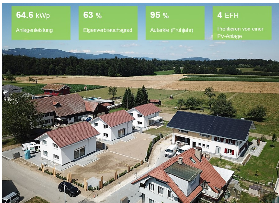
Abbildung 2: Integrierte PV-Anlage auf einem neugebauten Einfamilienhaus in Schwarzhäusern, welches drei Nachbargebäude (ebenfalls Neubauten) mit Solarstrom beliefert (Bildquelle: clevergie AG).
