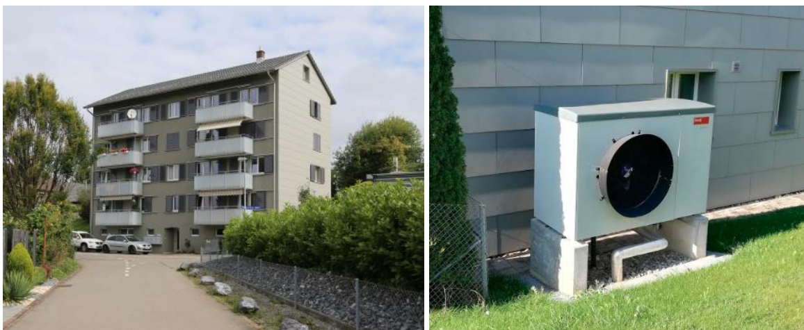
Abbildung 21: Ansicht der sanierten Liegenschaft; aussenaufgestellte Wärmepumpe nahe der Fassade auf Betonsockel. Quelle: voro Immobilien.
