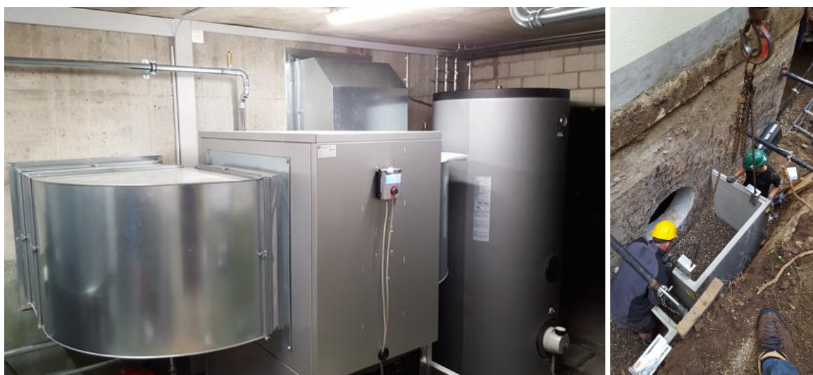
Abbildung 17: Links Innenaufgestellte Anlage im ehem. Tankraum; rechts Setzen der Lichtschächte am bestehenden Objekt. Quelle: Frei & Partner AG, Zwingen
