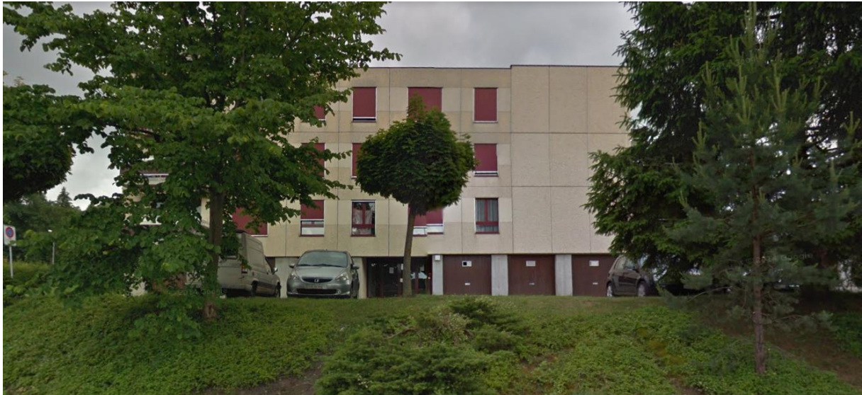
Abbildung 5: Das Gebäude vor der Sanierung. Quelle: Google Street View
