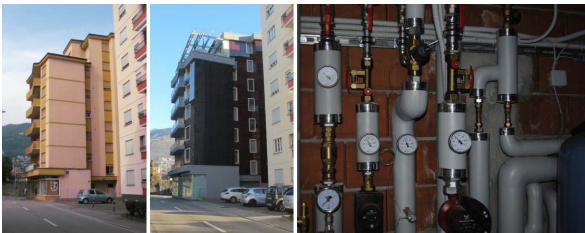
Abbildung 29: Ansicht Gebäude vor und nach der Sanierung, neuer Technikraum von innen.
