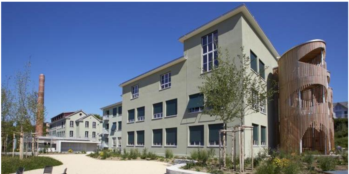
Abbildung 12: Ansicht der sanierten Gebäude. Quelle: Minergie.
