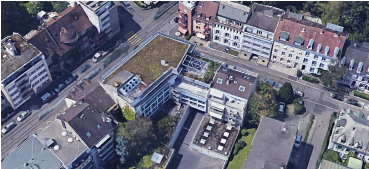
Abbildung 15: Satellitenbild des Gebäudes – gut sichtbar der schräg aufgestellte Rückkühler auf dem Flachdach. Quelle: Google Maps.
