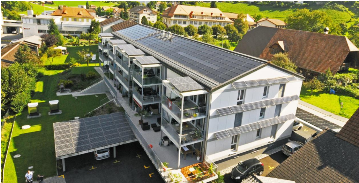
Abbildung 8: Ansicht des Gebäudes nach der Sanierung. Links im Garten stehen die beiden Wärmepumpen.
